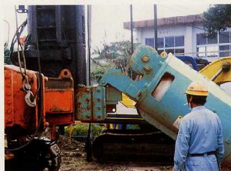
■ リーダへの組み付け作業
