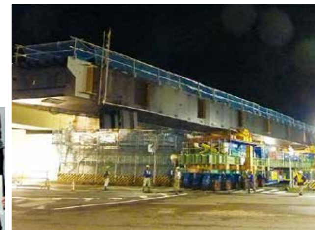
南中根高架橋 キャリアとユニットジャッキによる一括架設状況
