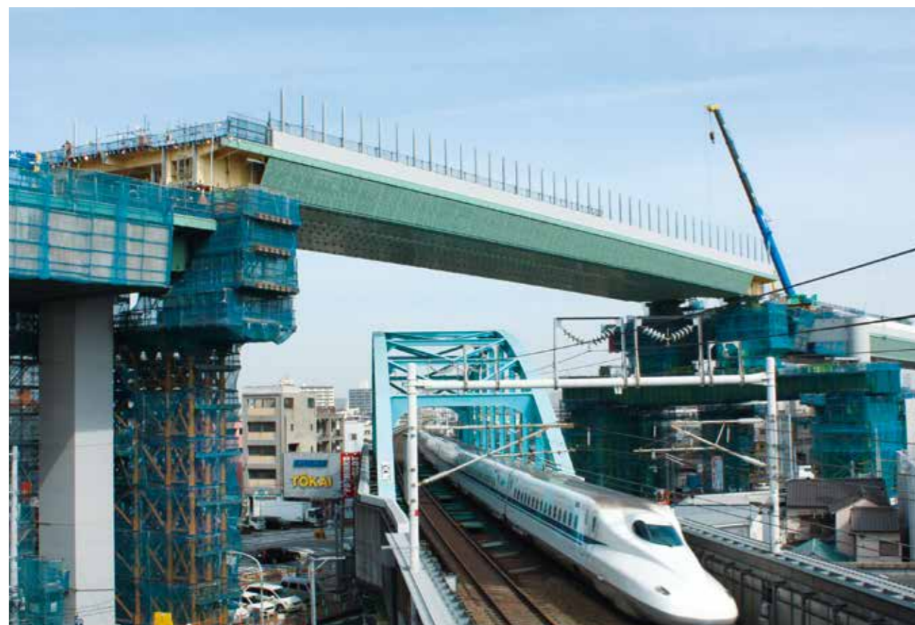
六番町跨線橋 架設工事
