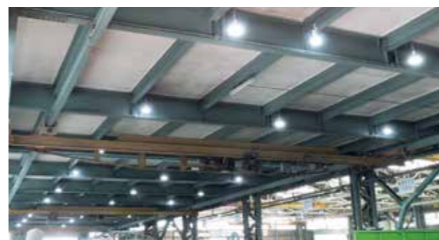
資材倉庫の照明更新
