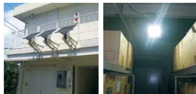
倉庫棟ソーラーパネル
