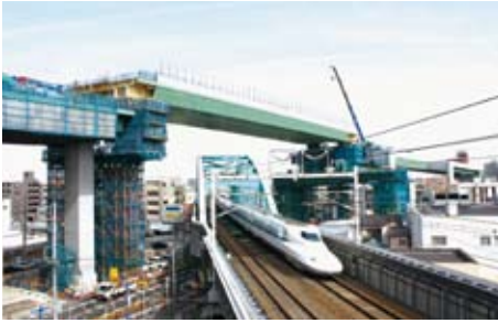
Overpass in Rokubancho
