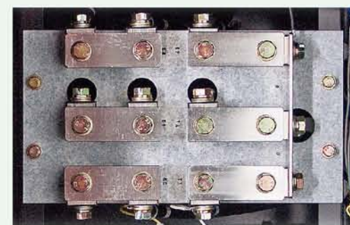
▲ 電圧切替端子板
