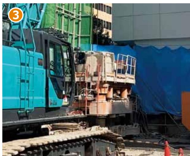
▲ケーシングの回転によってマルチグリッパが回転し、障害物を破碎する
