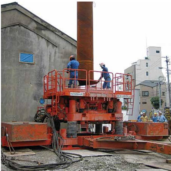
RT-150LIIによる鋼管杭施工状況
