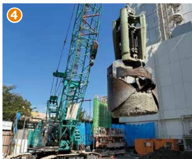
▲ハンマグラブ(他社製)で障害物を持ち上げ、撤去完了
