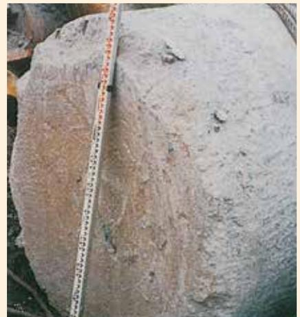
▲ 掘り出された鉄筋コンクリート基礎
