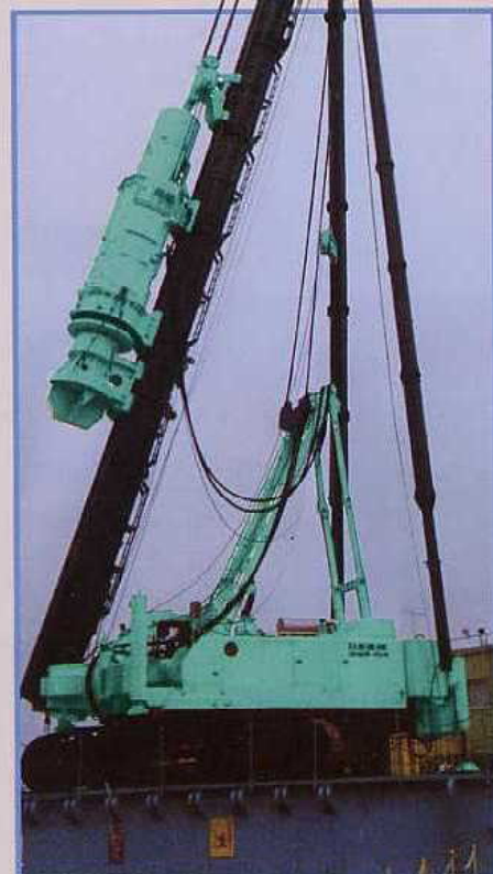
▲30Mリーダ斜杭作業
