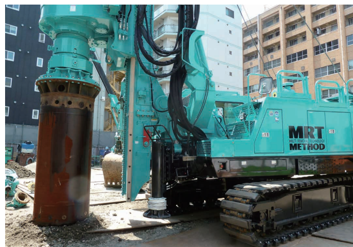
■ ケーシング掘削状況
