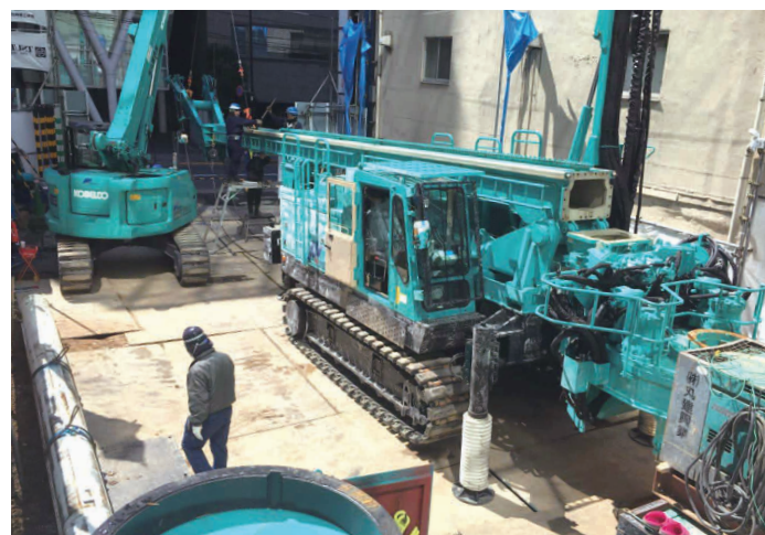
■ 狭隘地施工状況
