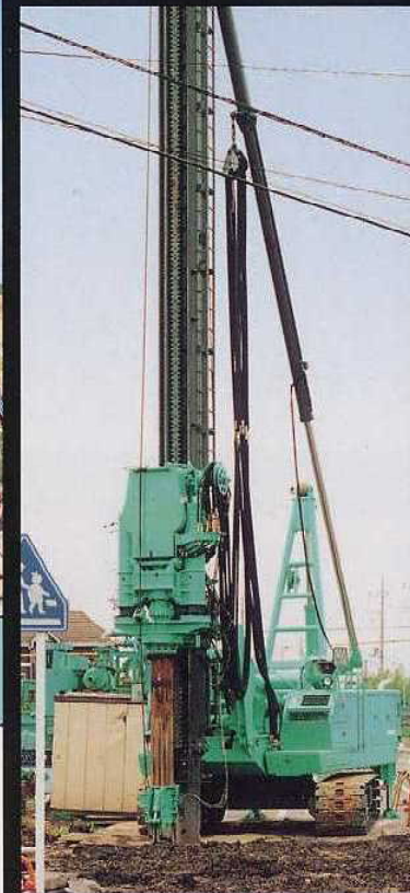
シート圧入作業
