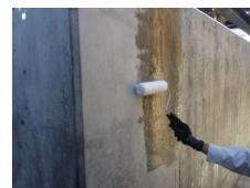
＜下塗り施工中＞
