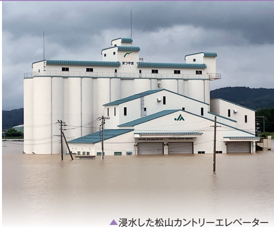
▲ 浸水した松山カントリーエレベーター
