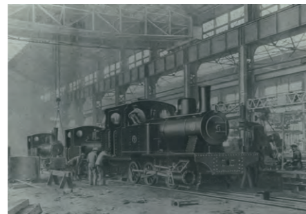
熱田本工場 機関車工場
