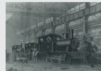
熱田本工場 機関車工場
