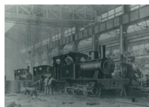
熱田本工場 機関車工場
