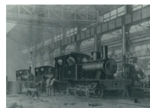
熱田本工場 機関車工場
