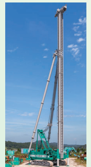
三点式大型杭打機
