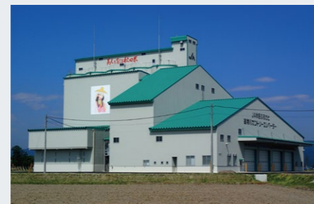
カントリーエレベーター
